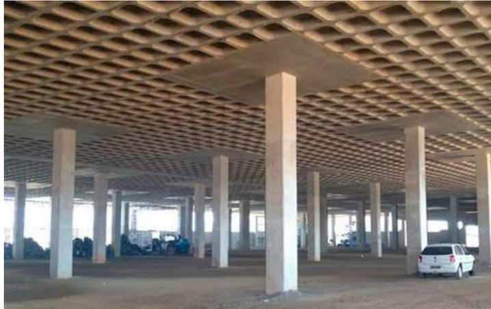
Ilustración 5. Losa reticular y columnas de concreto en estacionamiento. Tomado de [arquitecturapura.com](http://arquitecturapura.com) (consultado el 14/11/2020).
