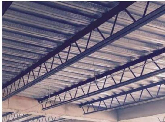
Ilustración 3. **Vigas Joist colocadas.**
