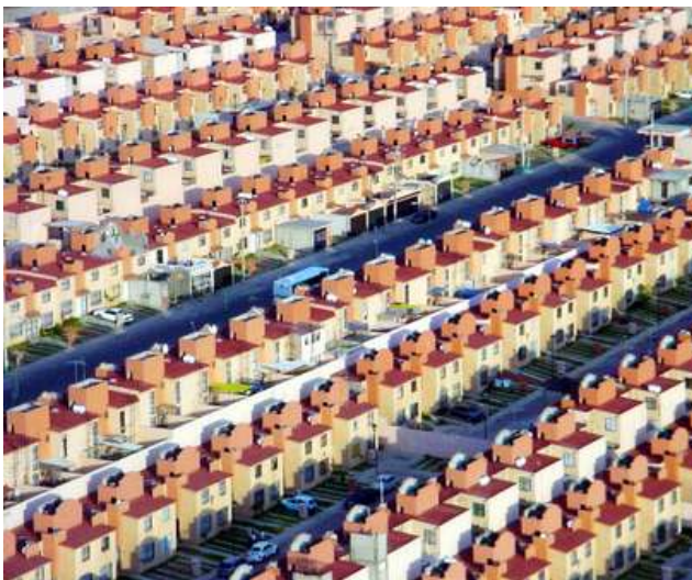
Imagen 2.-Casas GEO, en Tultitlán, Estado de México.
