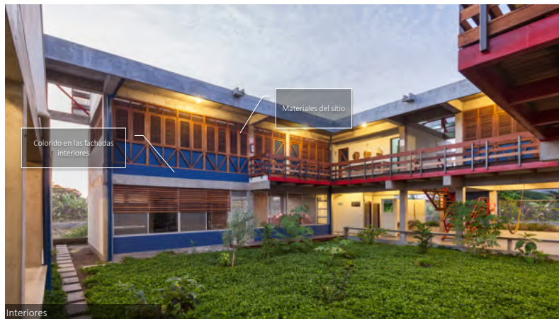
Ilustración 40 Fotografía interior. CASA ALBERGUE. Ecuador Consultado en: http://www.arquitecturapanamericana.com/casa-albergue/
