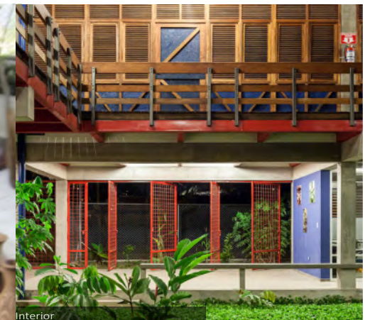
Ilustración 42 Fotografía interior. CASA ALBERGUE. Ecuador Consultado en: http://www.arquitecturapanamericana.com/casa-albergue/
