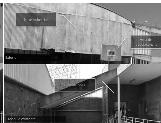
Ilustración 50 Fotografía exterior. CAFEMIN, Colonia Vallejo, Ciudad de México Tomado de: http://arquitectosconlagente.com/ruta-migrante-proyecto-cafemin/
