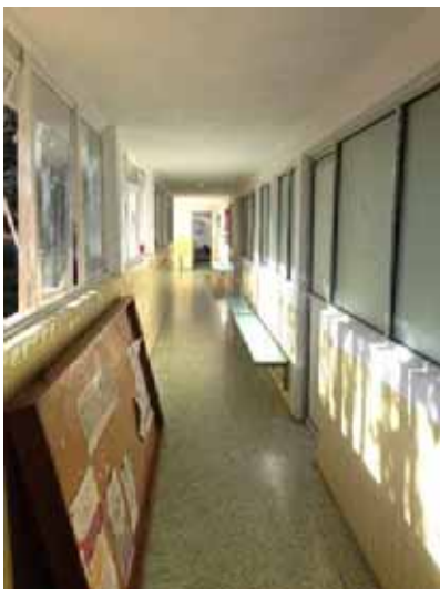
Ilustración 2. Pasillo del Centro de Salud de Zitácuaro 03-02-2020.
