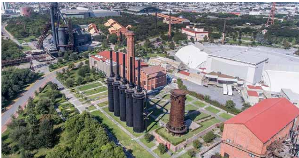
Ilustración 5. - Vista aérea de los hornos altos del Parque Fundidora. Obtenido de: https://files.parquefundidora.org/web/assets/og/og-home.663159de094c098881b996bd982834c5.jpg
