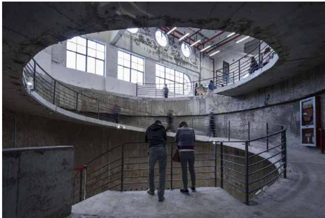
Ilustración 58.- Rampa helicoidal hacia el piso superior de los silos de Minsheng, por Atelier Deshaus. Obtenido de: https://www.arquine.com/wp-content/uploads/2020/07/arquine_atelier_deshaus_silos_minsheng_efimero_3.jpg
