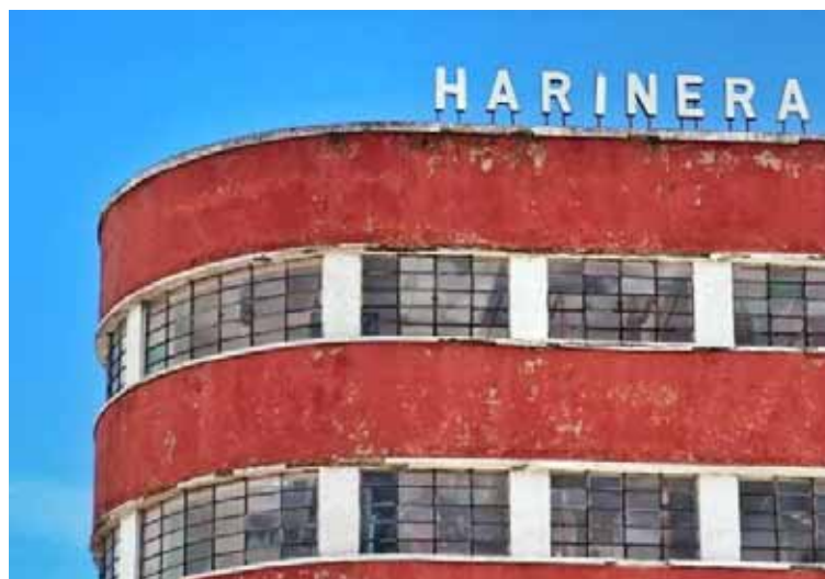
Ilustración 46.- Detalle del cuerpo de cribado de 1960 con visibles deterioros. Fotografía del autor.
