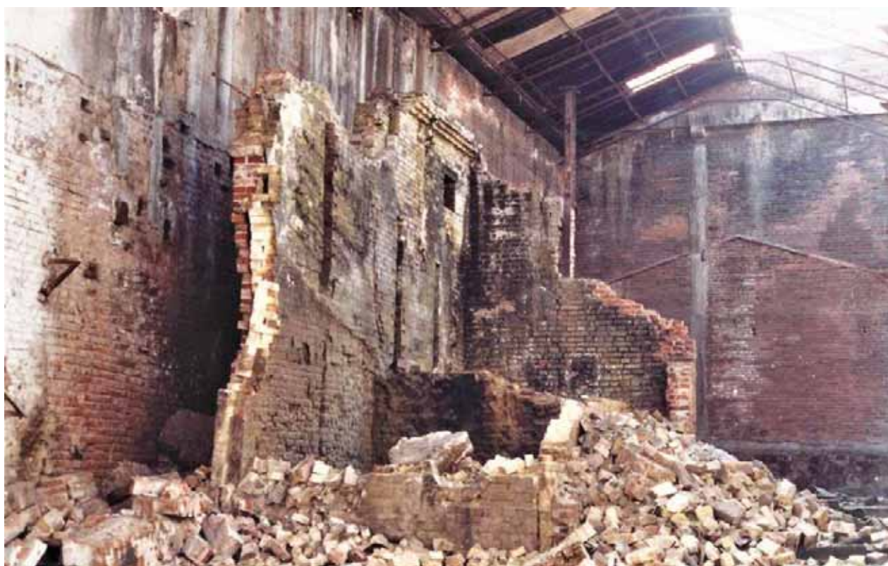
Ilustración 6. - Restos de la demolición de la antigua Aceitera Tron Hnos. Archivo de Navarro Franco.
