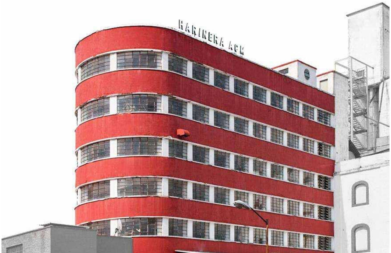
Ilustración 23.- Fachada curva del cuerpo de criba del conjunto "Harinera Michoacana". La jerarquía a las líneas horizontales, demarcadas por repisas de concreto y ventanas rectangulares son elementos característicos de los diseños de estilo internacional del Ing. Jaime Sandoval. Edición sobre fotografía original de Ettinger Mc Enulty. Obtenido de http://www.arq.umich.mx/guiarqsxx/web/industria/img/ind-03/01-03.jpg
