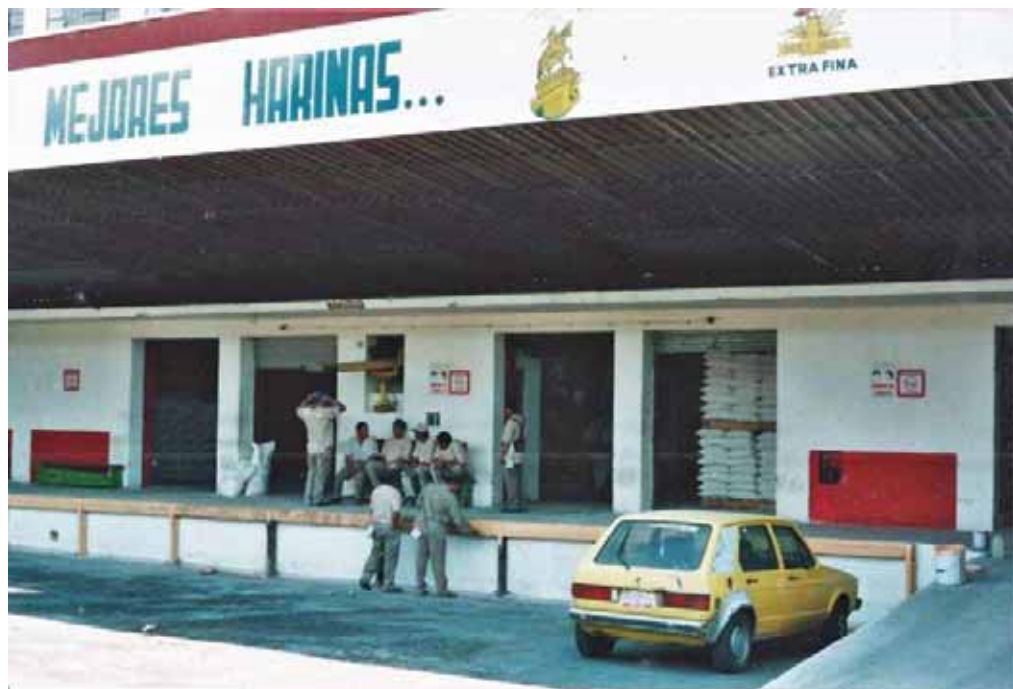
Ilustración 7.- Área de carga de producto terminado. Archivo de Navarro Franco, 2001.
