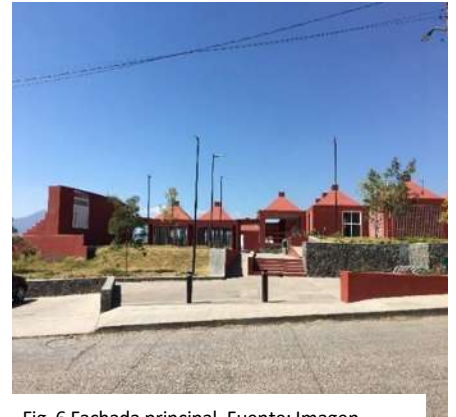
Fig. 6 Fachada principal. Fuente: Imagen propia
