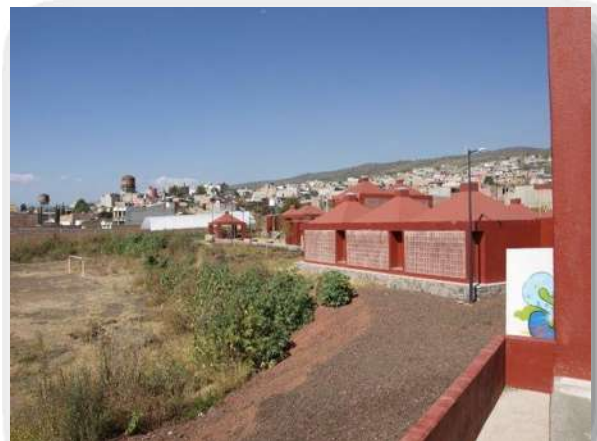
Fig. 21. Vista lateral Centro Bienestar. Fuente: imagen propia
