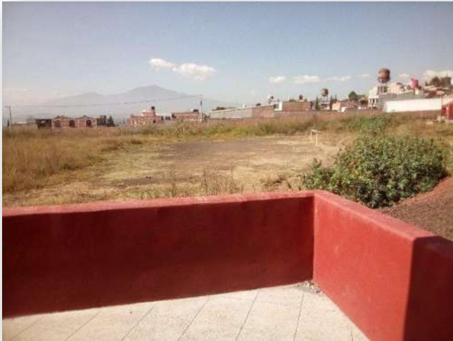
Fig. 24 Cancha deteriorada. Fuente: imagen propia
