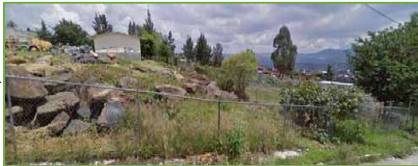
Imagen 31. Fotografía propia con vista al área del depósito de agua y la Escuela Primaria Juana de Asbaje
