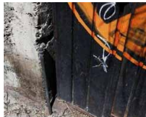
"Cuadro de distribución de agua potable" Foto: VGEC
