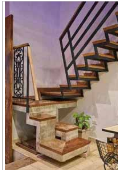
Ilustración 47 "Nucleo de Escaleras" Foto: Nestor Kim Enríquez
