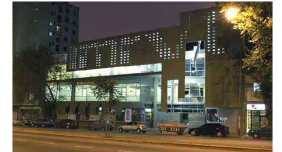
Ilustración 5: IMRVL fachada, Obtenida de: www.archdaily.mx
