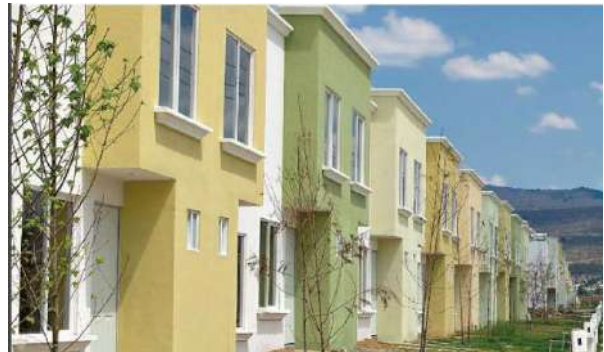
Imagen 20. Viviendas en Fracc. Villas del Pedregal Morelia, Michoacán. Fuente: Google Maps [Octubre 2020]
