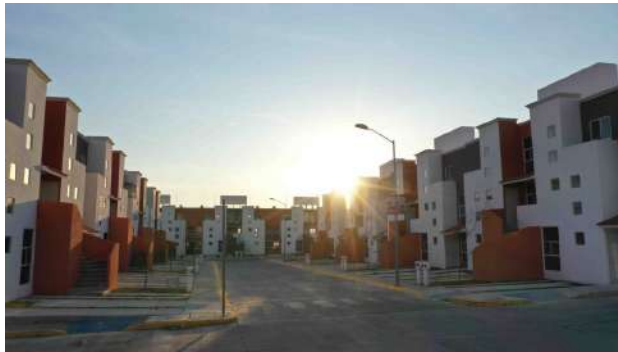
Imagen 19. Viviendas en Fracc. Villas del Pedregal Morelia, Michoacán. Fuente: Google Maps [Octubre 2020]
