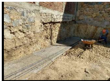
Ilustración 33 habilitado de parrilla de zapata corrida, a base de varde 3/8".
