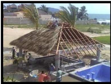
Ilustración 76 construcción de palapa a base de madera de bejuco, y de palma.
