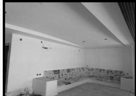
Ilustración 61 plafond de Tablaroca, con cajillo luminoso y pasta color hueso.
