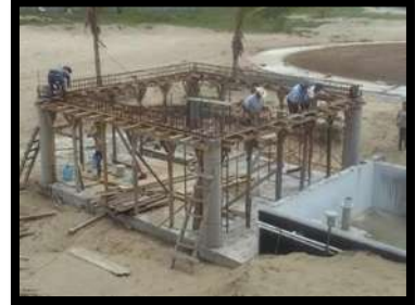
Ilustración 81 se coló un firme 20 cms a esa base de zapatas aisladas unidas.
