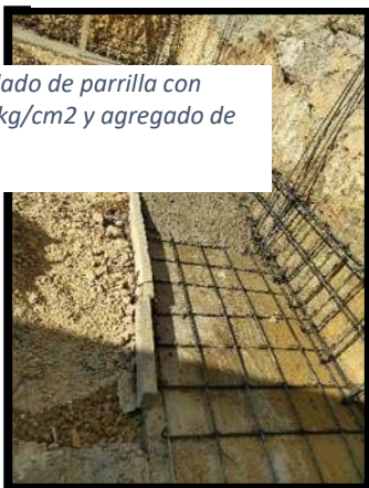
Ilustración 34 Maestras, son las que indican el nivel que tendrá la plantilla.
