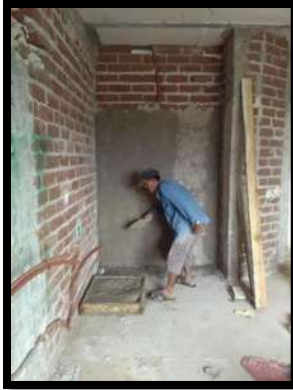
Ilustración 49 al inicio de la segunda etapa, todo estaba en obra gris.
