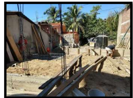
Ilustración 31 cimbrado y colado de zapata corrida habilitado de cadena de 15x35 cms de sección armada con var de 1/2" y estribos no. 2 a cada 15 cm.
