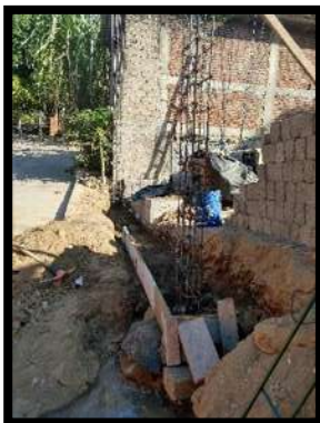
Ilustración 38 habilitado, cimbrado y tabicón de concreto de 10x14x28 cms de colado de castillo a base de 4 var de 14 cms de espesor, junteado con mortero, 3/8" y 2 var de 1/2".
