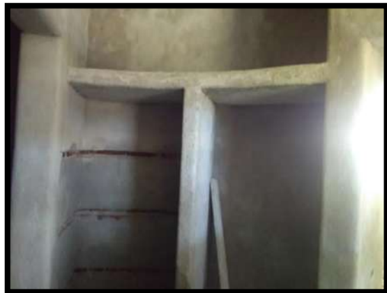
Ilustración 45 se aplanan fino con esponja en todos los muebles y todo el departamento.
