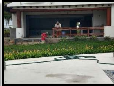
Ilustración 77 construcción de piso cerroteado en área de alberca.
