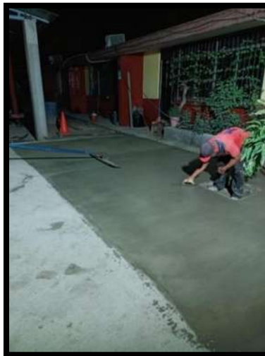
Ilustración 93 Colado de firme de 15 cm de espesor, de f'c 250 kg/cm2. En plaza cívica con un área de 32.50 x 15.80 mts.
