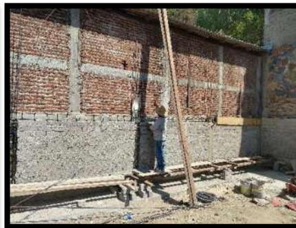
Ilustración 40 cadena intermedia de 15x25 cms armada con varilla de 3/8".
