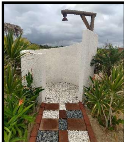
Ilustración 83 construcción de regadera a base de materiales de la región.
