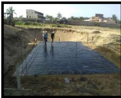
Ilustración 75 colocación de plástico que funciona para trabajar en limpieza y como impermeabilizante entre la arena y el fierro
