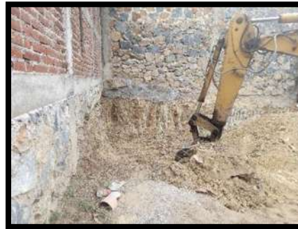
Ilustración 35 Despalme y corte de terreno, para comenzar el trazo y la nivelación.
