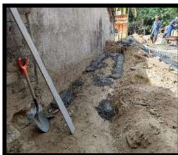
Ilustración 34 Maestras, son las que indican el nivel que tendrá la plantilla.
