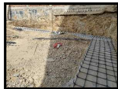
Ilustración 32 Plantilla de concreto pobre f'c 150kg/cm 2 hecho en obra.
