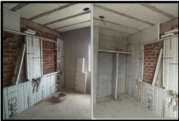
Ilustración 46 se comienza a colocar el panel w para hacer los muebles fijos tales como cabecerales y nichos para A/A. en las recamaras.
