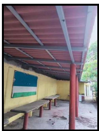
Ilustración Fabricación de techo en área de comedor.
