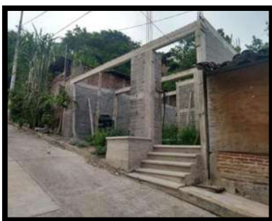
Ilustración 37 finalizó la primera etapa en la cual, se llegó hasta las cadenas de cerramiento. Para finalmente en la segunda etapa continuar con la losa, las instalaciones y obra gris.
