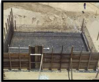
Ilustración 73 cimbrado de alberca y colocación de instalación.
