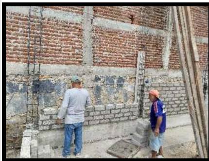
Ilustración 39 construcción de muro de
