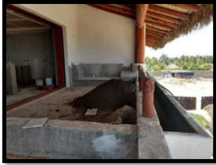
Ilustración 59 palapa con madera de la región, bocote y rollizos de 4"
