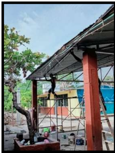
Ilustración 94 Fabricación de techumbre
