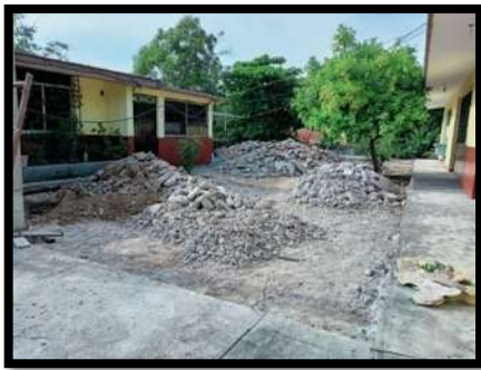
Ilustración 90 Demolición de firme existente, mediante rotomartillo.
