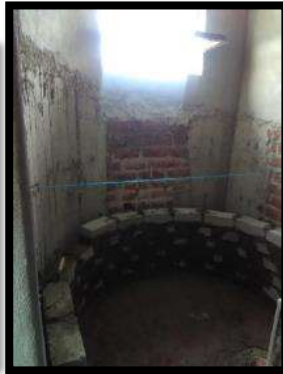
Ilustración 54 construcción de sala a base de tabicón cemento, arena y grava, parte de lregadera a base de tabicón albañilería.
