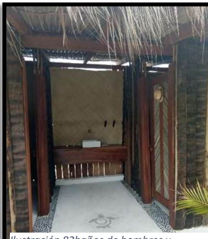
Ilustración 82 baños de hombres y mujeres hechos con materiales de la región.
