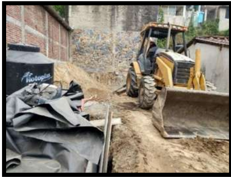
Ilustración 35 Despalme y corte de terreno, para comenzar el trazo y la nivelación.
