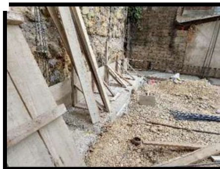
Ilustración 31 cimbrado y colado de zapata corrida habilitado de cadena de 15x35 cms de sección armada con var de 1/2" y estribos no. 2 a cada 15 cm.
