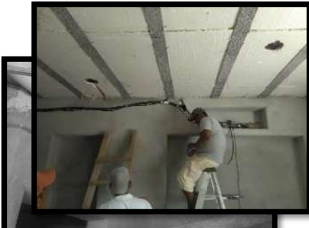
Ilustración 50 se comienza la instalación de los A/A
