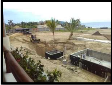
Ilustración 79 ya que se coló la alberca, se hace la impermeabilización.
