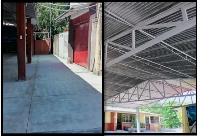
Ilustración 96 Finalización de firme de concreto.
