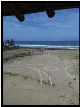
Ilustración 70 trazo de las áreas exteriores y de la alberca.
