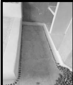
Ilustración 60 piedra decorativa tipo bolillo de 3 cms en piso.
