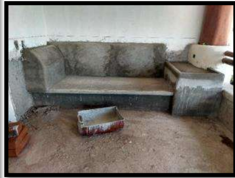
Ilustración 53 finalmente los muebles después de ser terminados se aplanaron.
