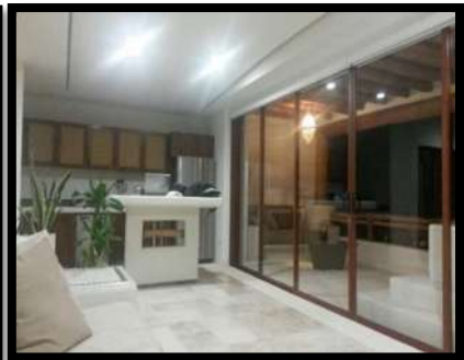
Ilustración 62 luminarias tipo spot empotradas en el plafón, y cajillo luminoso.
