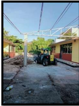
Ilustración 92 Carga y acarreo mediante flor clip.
