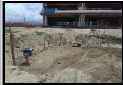
Ilustración 72 corte del área de la alberca, mediante retroexcavadora.
