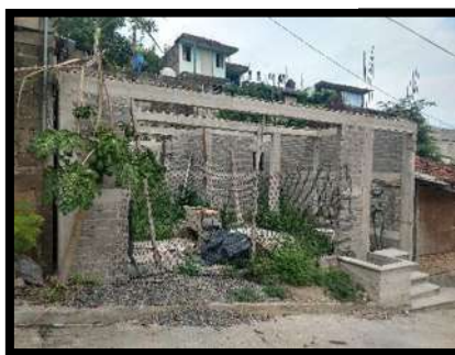
Ilustración 37 finalizó la primera etapa en la cual, se llegó hasta las cadenas de cerramiento. Para finalmente en la segunda etapa continuar con la losa, las instalaciones y obra gris.
