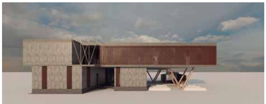
Figura 48. Fachada con estructura tubular al final de pasillos superiores y placas de concreto premoldeado.
