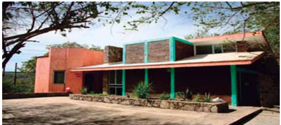
Figura 2. Patio interior de estación Biológica Chamela.
