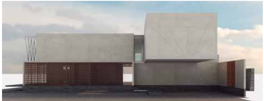
Figura 52. Fachada principal con un bloque suspendido en planta alta que resguarda el acceso.
