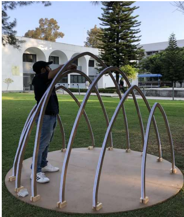
Fig.90 Armado final de la estructura.
