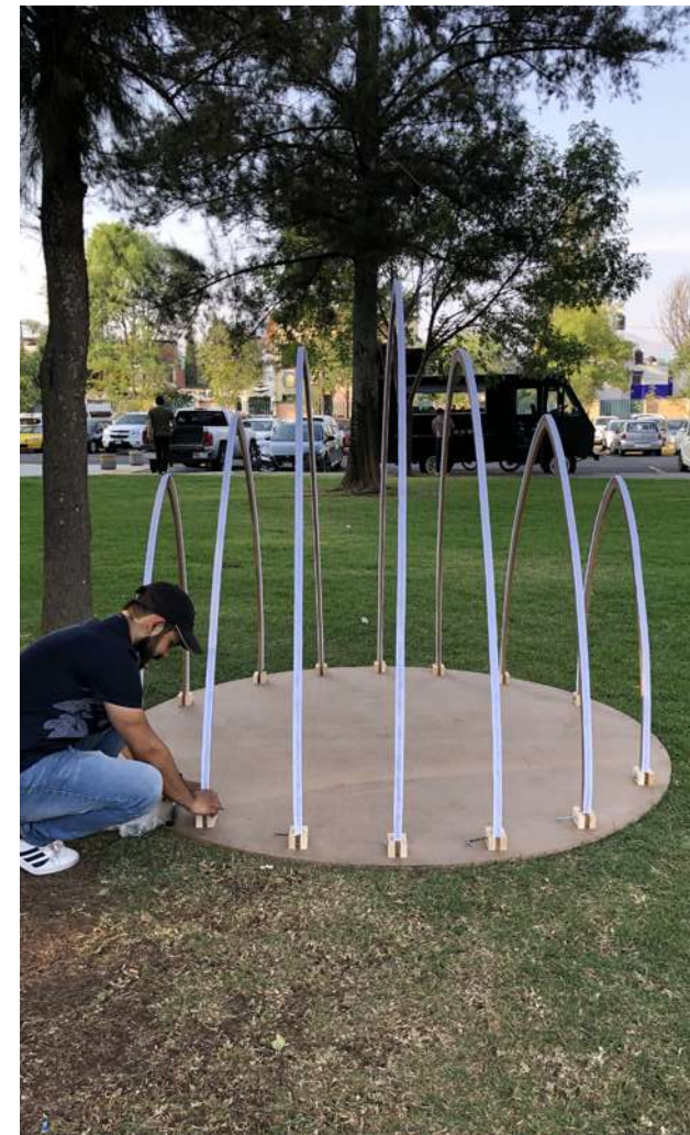
Fig.82 Perfiles con velcro para tensar y fijar la cubierta de tela.
