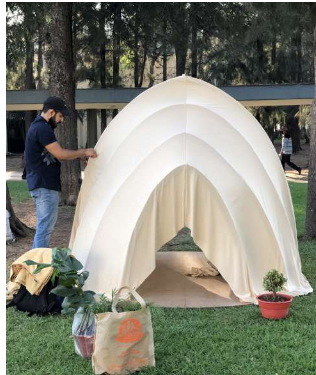
Fig.92 Colocación final de cubierta de tela.
