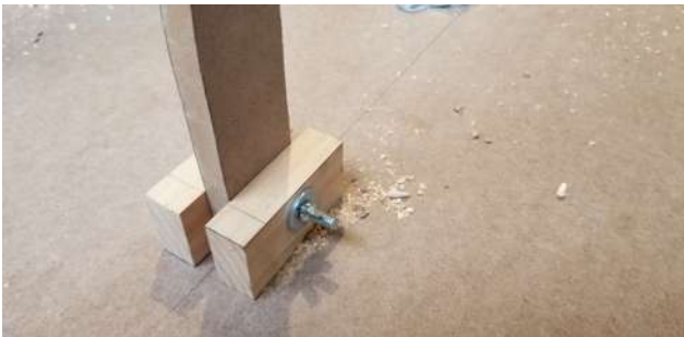
Fig.78 Sistema de anclaje con tornillo 2 1/2”. 2
