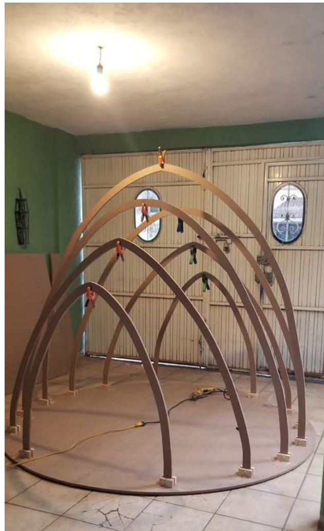
Fig.80 Perfiles anclados en la base.
