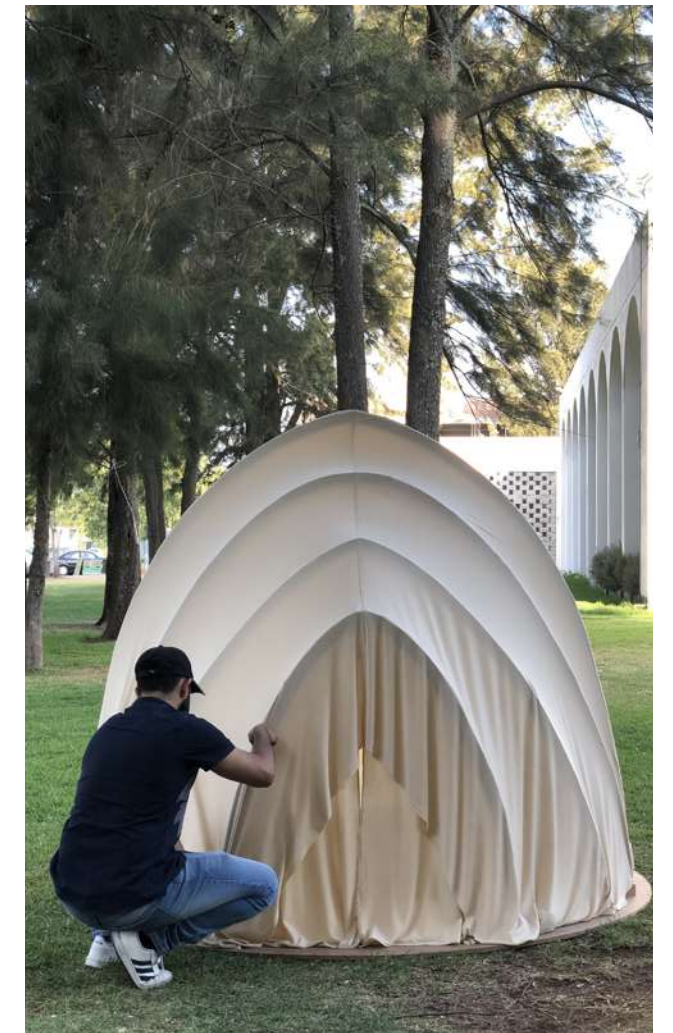
Fig.83 Tensado de la tela sobre los perfiles con velcro.
