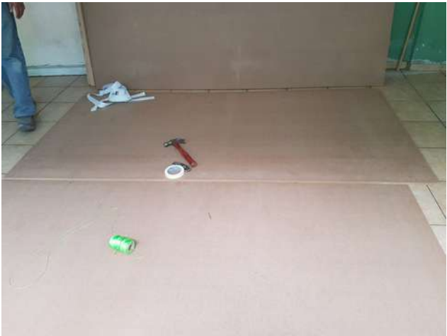
Fig.66 Trazado de la base sobre panel de mdf.
