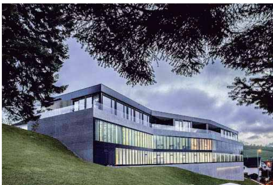
Imagen 7. Vista frontal de la clínica Bellavista.
