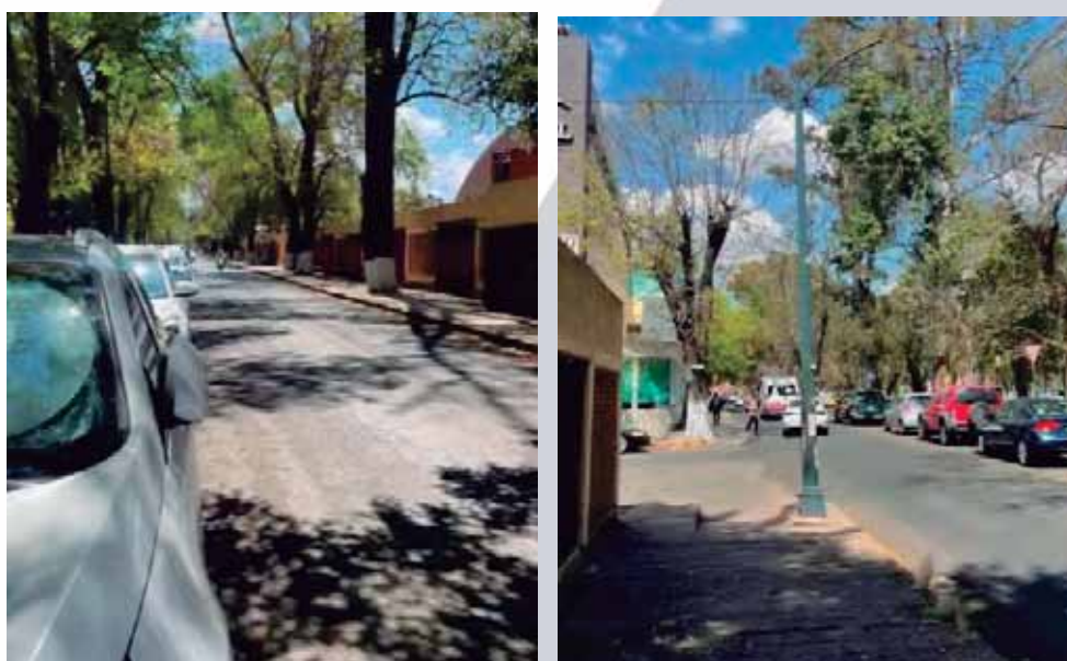
Ilustración 50. Fotografías tomadas en visita a sitio. Calles con recubrimiento.
