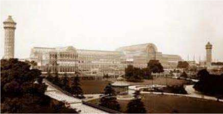
Imagen 4- Vista del palacio de cristal de Londres 1851. FUENTE: La arquitectura del hierro en la segunda mitad del s. xix P-5
