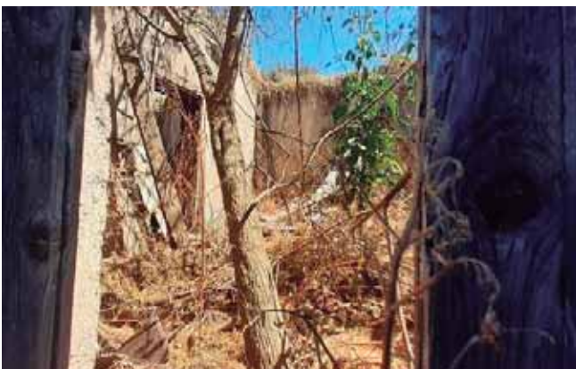
Imagen 50. Casa abandonada. Foto tomada por Juan Carlos Juarez Urquiza (fecha 7 de septiembre de 2021)
