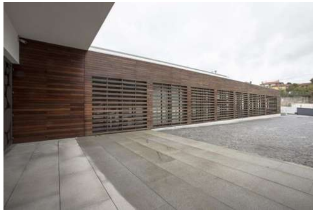
15 edificio Residencial para Adultos Mayores. segunda estructura.
