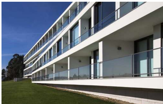
16 Edificio Residencial para Adultos Mayores. vista exterior
