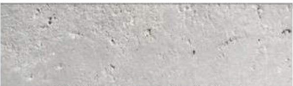
Concreto gris aparente y pulido en muros
