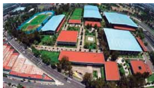
Ilustración 38 Vista de conjunto CNAR
