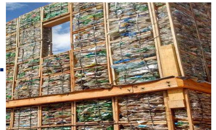
Ilustración 70. Prototipo de vivienda con PET en Argentina. En base a la fuente: https://www.archdaily.mx/mx/908200/este-sistema-modular-de-plastico-recuperado-aborda-la-vivienda-de-bajo-impacto-ambiental-en-argentina
