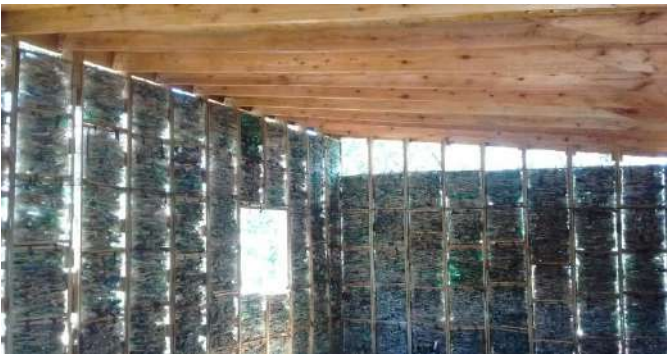
Ilustración 83. Prototipo de vivienda con PET en Argentina. En base a la fuente: https://www.archdaily.mx/mx/908200/este-sistema-modular-de-plastico-recuperado-aborda-la-vivienda-de-bajo-impacto-ambiental-en-argentina
