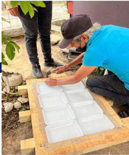
Relleno del Material de Unicel
