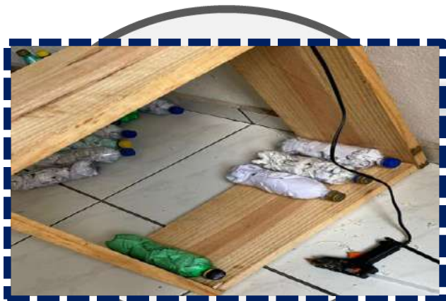
Colocación del pegamento en los eco-ladrillos
