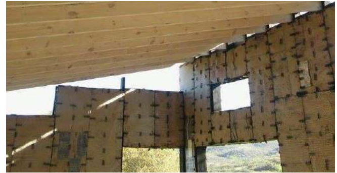
Ilustración 85. Prototipo de vivienda con PET en Argentina. En base a la fuente: https://www.archdaily.mx/mx/908200/este-sistema-modular-de-plastico-recuperado-aborda-la-vivienda-de-bajo-impacto-ambiental-en-argentina
