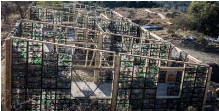
Ilustración 82. Prototipo de vivienda con PET en Argentina. En base a la fuente: https://www.archdaily.mx/mx/908200/este-sistema-modular-de-plastico-recuperado-aborda-la-vivienda-de-bajo-impacto-ambiental-en-argentina
