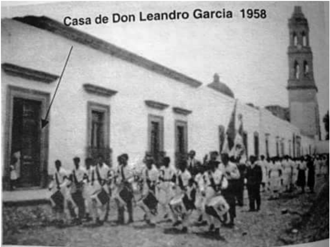
Fig. 16.- Fachada principal de la casa de don Leandro García, 1958 Autor: Alfredo Olvera Velázquez
