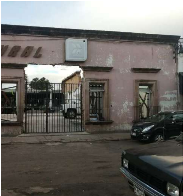
Fig. 24. - Fachada parte derecho Autor: KPB Octubre, 2021.
