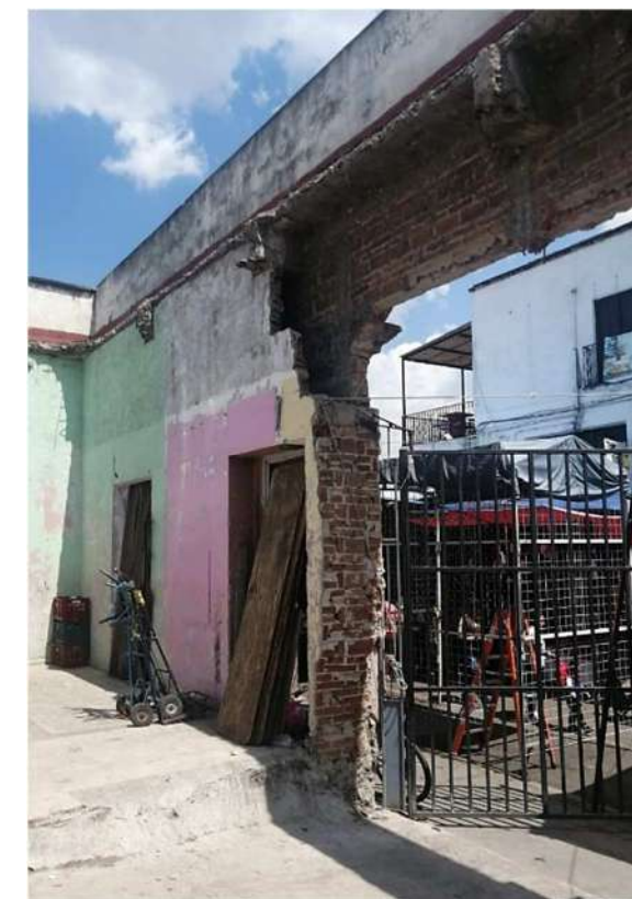
Fig. 27.- Muro de la fachada, visto desde el interior. Autor: KPB Abril, 2022
