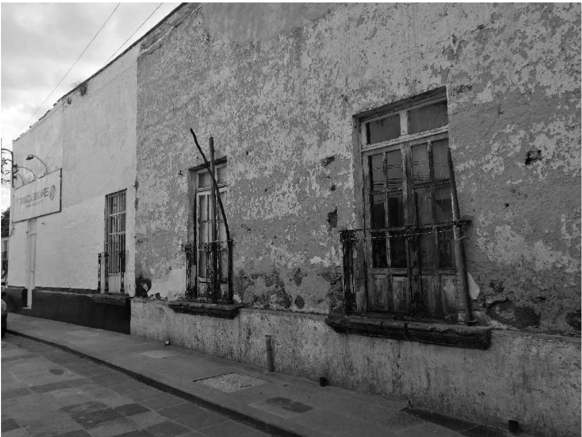
Fig. 06.- Fachada lateral del inmueble actual Autor: KPB. Octubre, 2022.
