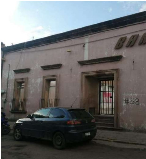
Fig 22.- Fachada parte izquierdo Autor: KPB Octubre, 2021.
