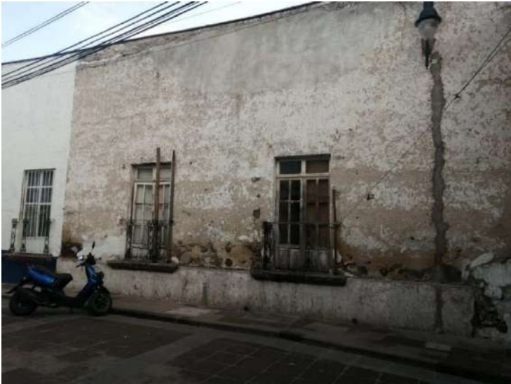
Fig. 11.- Fachada lateral del inmueble actual Autor: KPB Septiembre, 2021.
