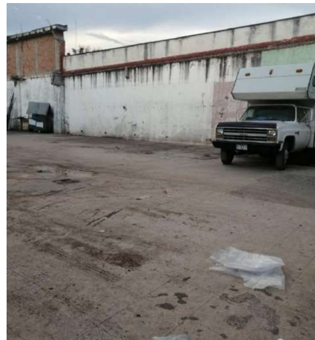
Fig. 27.- Interior parte derecha Autor: KPB Octubre, 2021.
