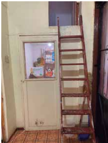
Fig 36. Fotografía Exterior de Bodega de Alimentos. Fotografía Propia. Tomada: 20-09-2021
