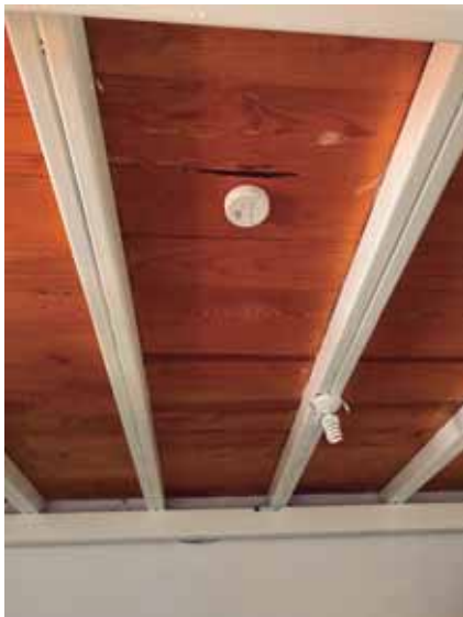
Fig 28. Fotografía Techo en Consultorio. Fotografía Propia. Tomada: 20-09-2021
