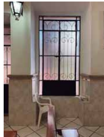
Fig 21. Fotografía Ventanas en Capilla. Fotografía Propia. Tomada: 20-09-2021
