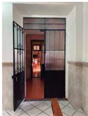
Fig 20. Fotografía Acceso a Capilla por Pasillo de Acceso al Segundo Edificio. Fotografía Propia. Tomada: 20-09-2021
