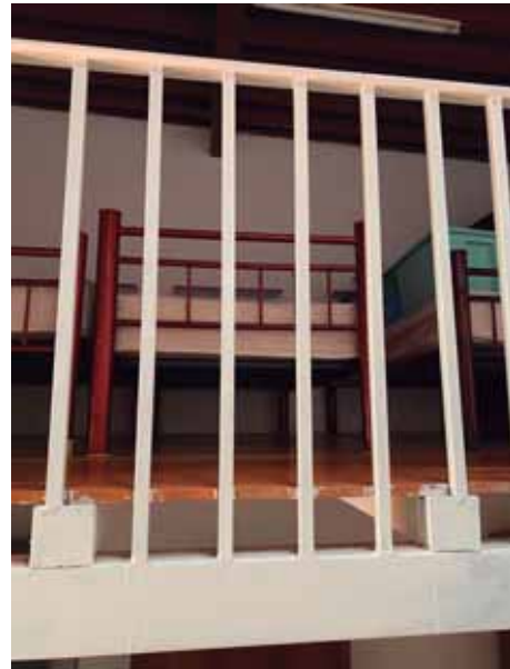
Fig 27. Fotografía Unión de Perfil y Madera. Fotografía Propia. Tomada: 20-09-2021
