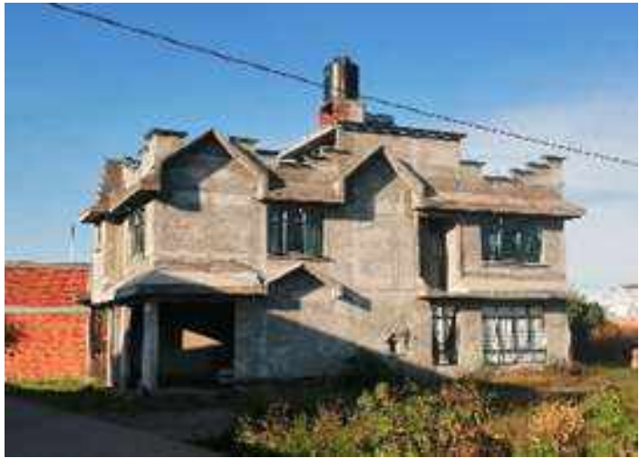
Foto 83. Casa ubicada cerca del terreno. 2021, Fuente: propia, Luis Eduardo Pérez Gallegos.
