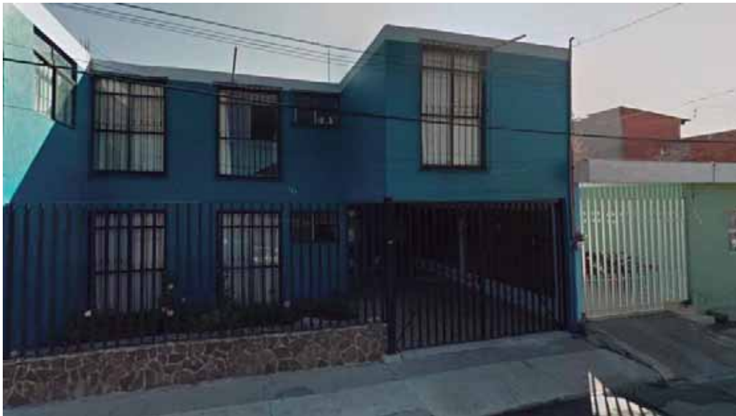
Imagen No. 33. Vivienda en la calle Ignacio Zaragoza. Fuente: Google Maps.
