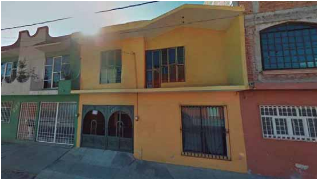
Imagen No. 34. Vivienda en la calle Zinc. Fuente: Google Maps.
