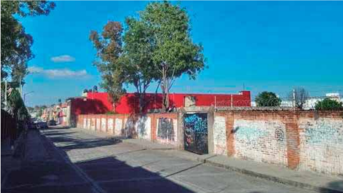
Imagen No. 8. Fachada Oeste del predio. Fuente: Autoría propia.
