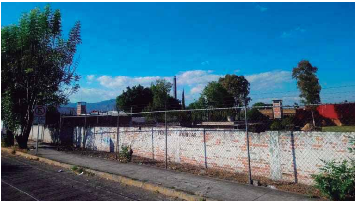
Imagen No. 9. Fachada Sur del predio. Fuente: Autoría propia.
