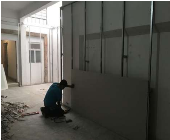
Imagen 42.- " Muros de tablaroca"
