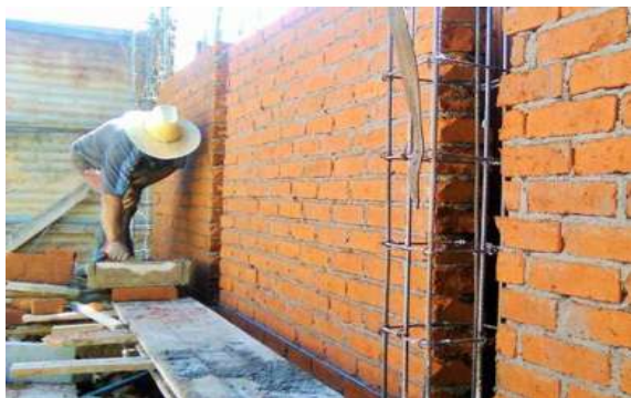
Imagen 42.- "Muros de tabique"
