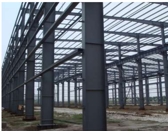
Imagen 40.- " Columnas de metal"
