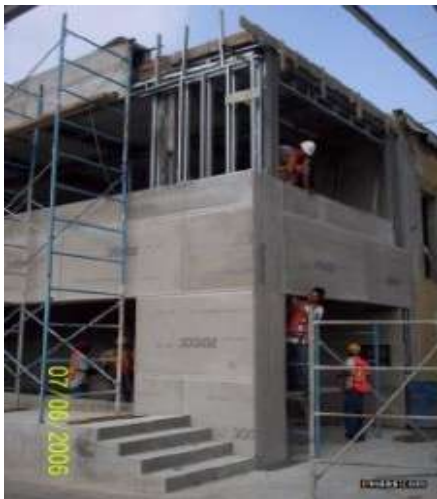
Imagen 42.- " Muros de durock"
