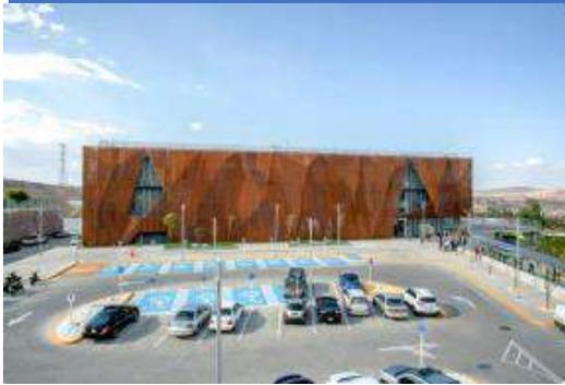
Se llegó a la conclusión que el material ideal a utilizar en esta sección sería una lámina ondulada, ya que tiene mayor resistencia que un panel liso y permite un espesor de tan solo 0.8 mm. Esto permite disminuir el peso global en la fachada.
