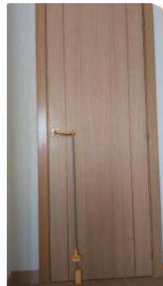
**Imagen. 188.** Mecanismo para abrir con los pies las puertas.
