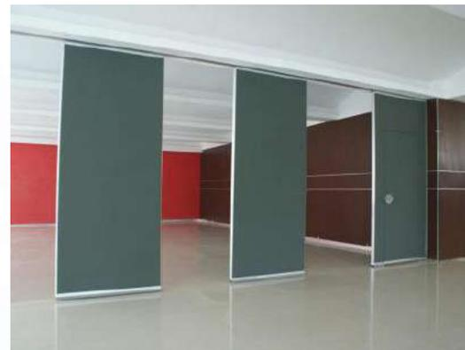
**Imagen. 116.** Ejemplo de muro móvil.
