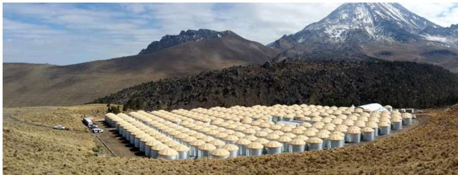
Figura 5.5: Arreglo completo de los 300 *WCD* de *HAWC*. El observatorio cuenta con un amplio campo de visión y puede tomar mediciones de día o de noche sin importar las condiciones climatológicas. El observatorio cuenta con una única construcción al centro del arreglo, en él se encuentra el centro de adquisición de datos (*counting house*). Fuente imagen: colaboración *HAWC*.
