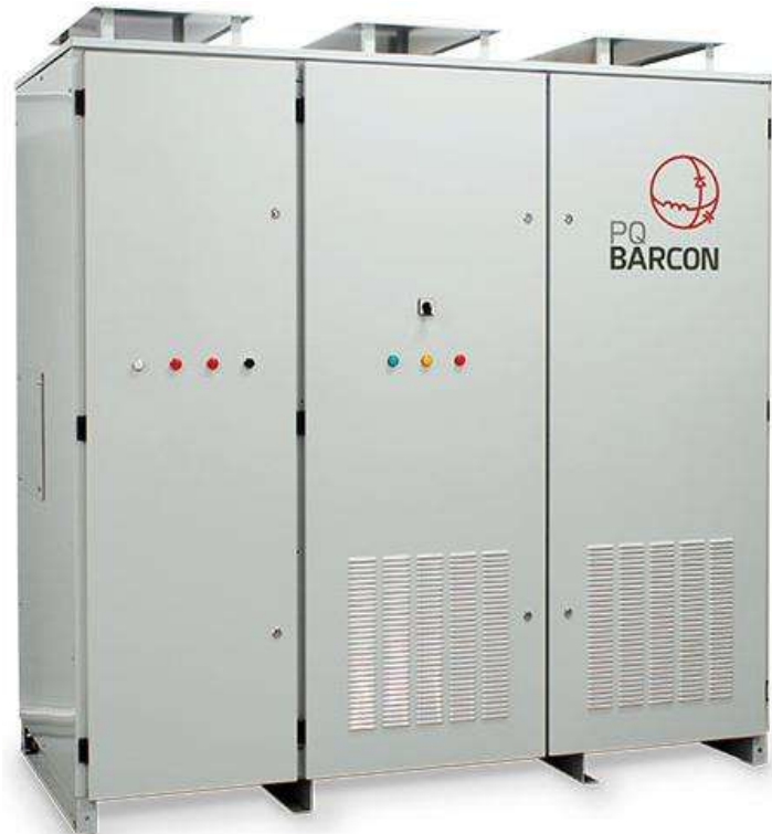
Figura 4.6. Vista exterior de un filtro activo. Fuente: www.pqbarcon.com .
