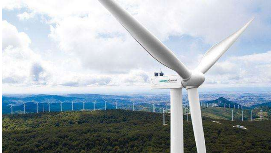
Figura 3.1. Aerogenerador SG 5.8-170. Fuente: siemensgamesa.com .
