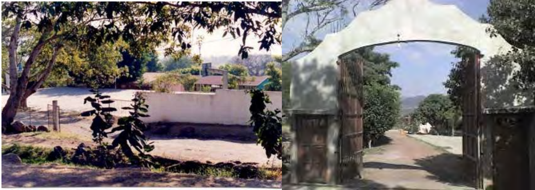
ENTRADA PRINCIPAL SIN PUERTA DE ACCESO (2005) POSTERIORMENTE SIN PINTAR (2009)
