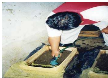
Fig. 13 Suministro de agua
