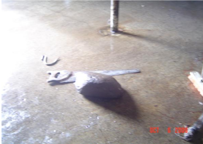
Imagen que muestra equipo incorrecto para realizar el corte de canales en el municipio de (Copandaro)
