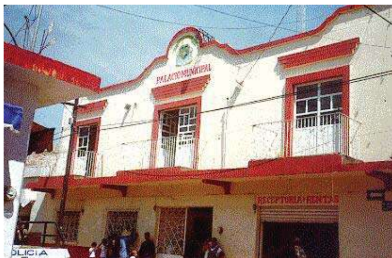
Foto 2: Palacio municipal en el municipio de Tuzantla
