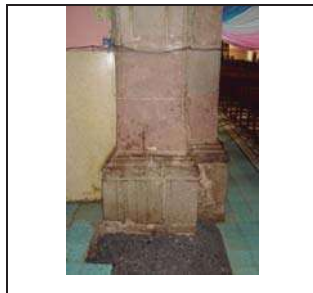
En esta esquina se pueden observar varios de los materiales de construcción del templo
