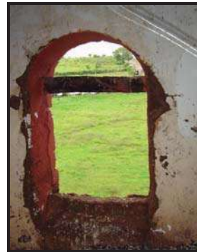
Ventana de la torre
