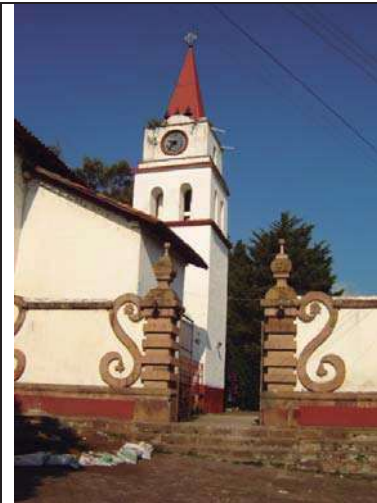
Vista de la torre fuera de la barda
