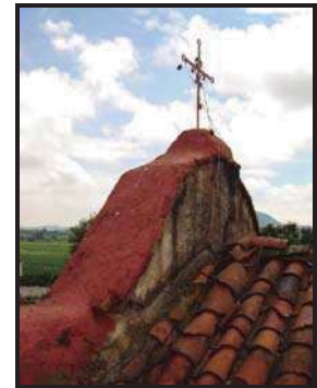
Vista a la parte trasera de la fachada
