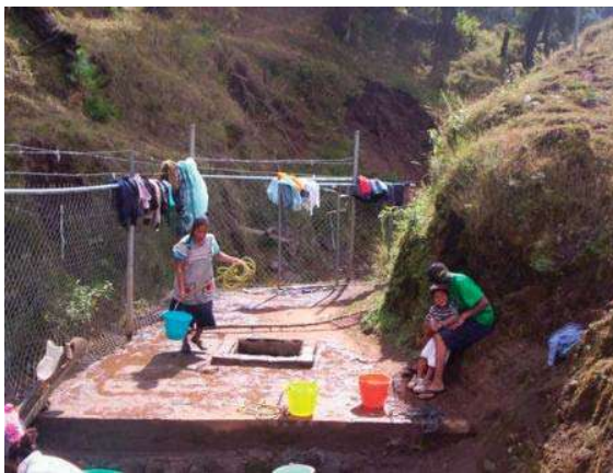
Las Norias de filtración de agua
