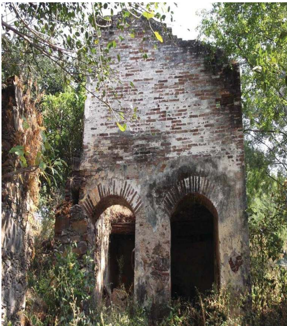
Arcos de la construcción del edificio principal.
