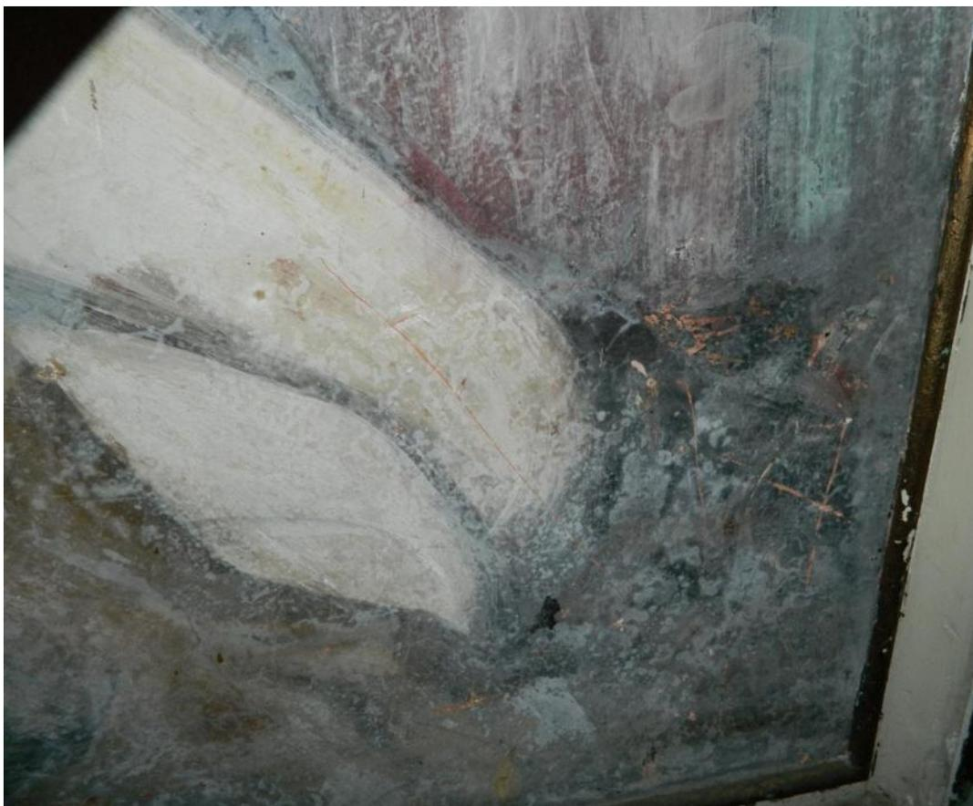
Imagen 43: Detalle del deterioro de la zona inferior derecha del mural *El Alba*.
