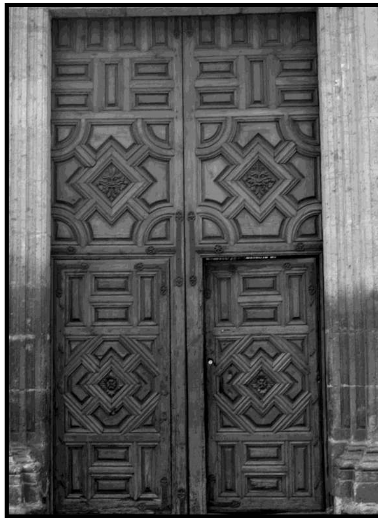
Imagen 21. Puerta principal de la casa de don Isidro Huarte.
