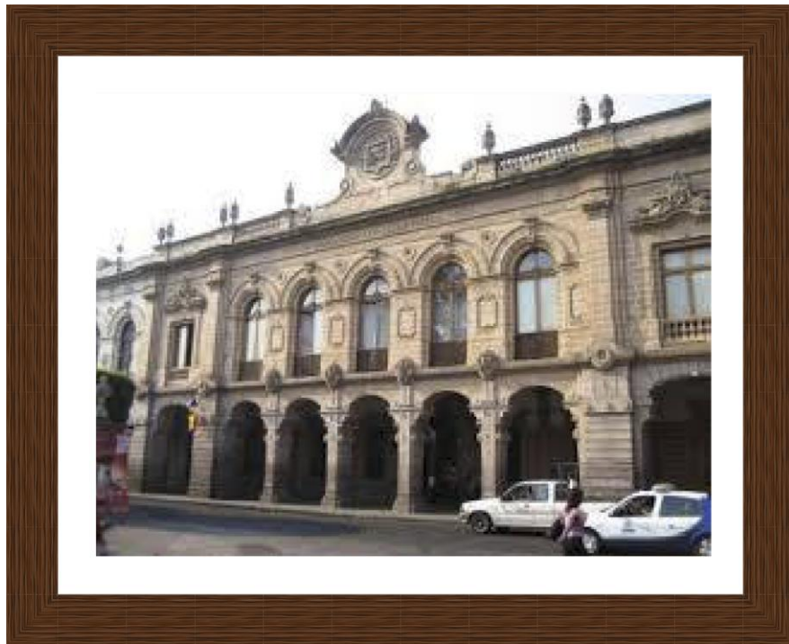
Edificio que aloja el Archivo Histórico del Poder Judicial del Estado de Michoacán, Portal Allende, # 267, Centro Histórico.
