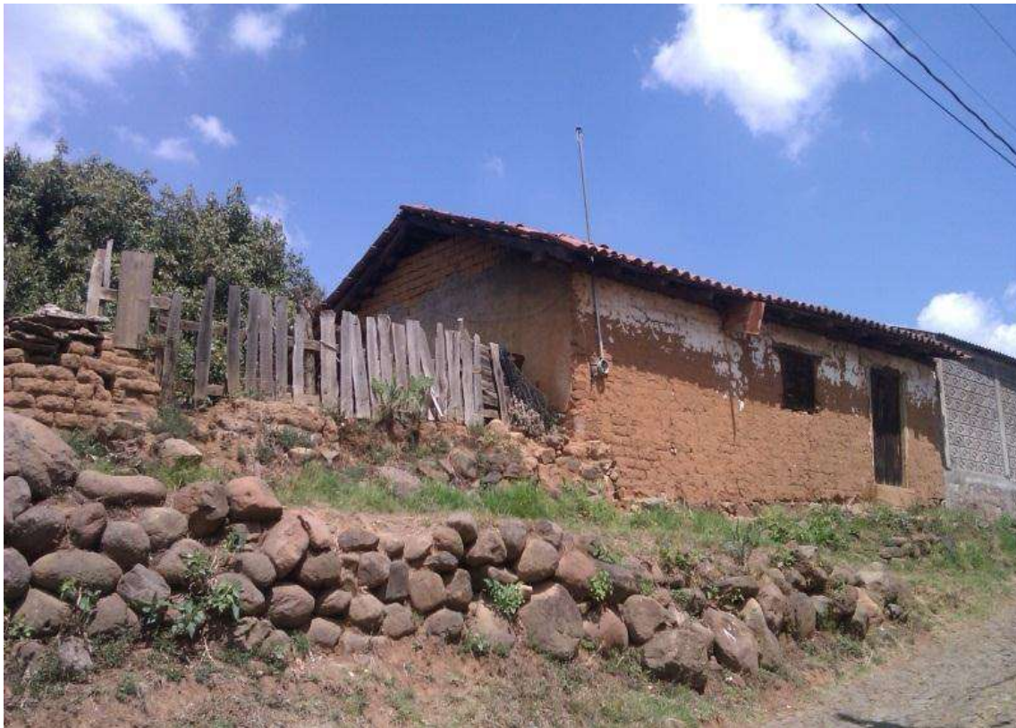
Foto: Nambo (2015). Son abundantes este tipo de casas en Tupátaro, contrastan con las construcciones de concreto y doble planta.
