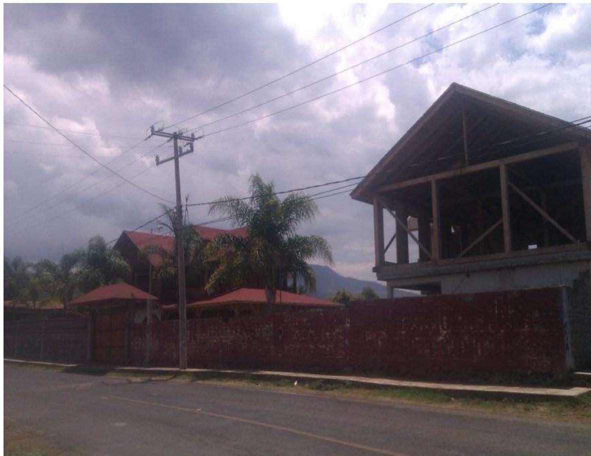
Fotografía 6. Construcción en las afueras de Tupátaro sin características típicas de la comunidad.
