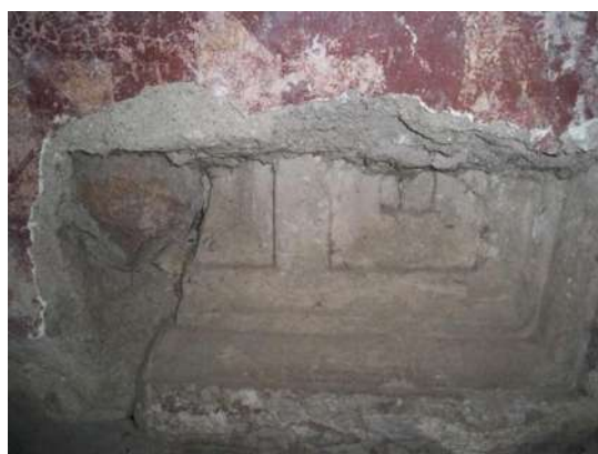
IMAGEN 2 Materiales de Construcción
