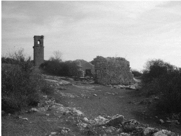
Templo de Santa María de los Urdiales. Ruinas del terremoto 1808. 171
