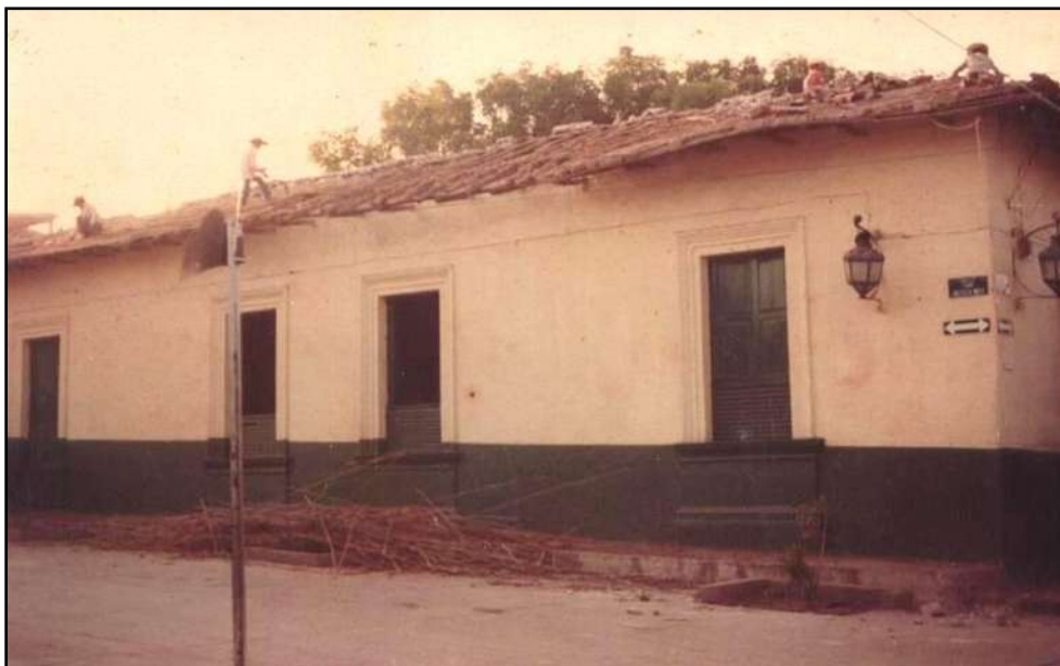
Demolición de la Casa Municipal, ubicada en las calles Av. Madero Norte esquina Fray Juan Bautista Moya (Foto de la Srita. Margarita Soto Yáñez)
