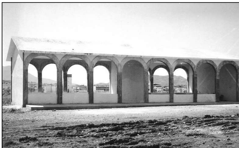
Construcción de aula y laboratorio de la Escuela Preparatoria "Lic. Benito Juárez" (Foto de J. Jesús Peña Navarrete)
