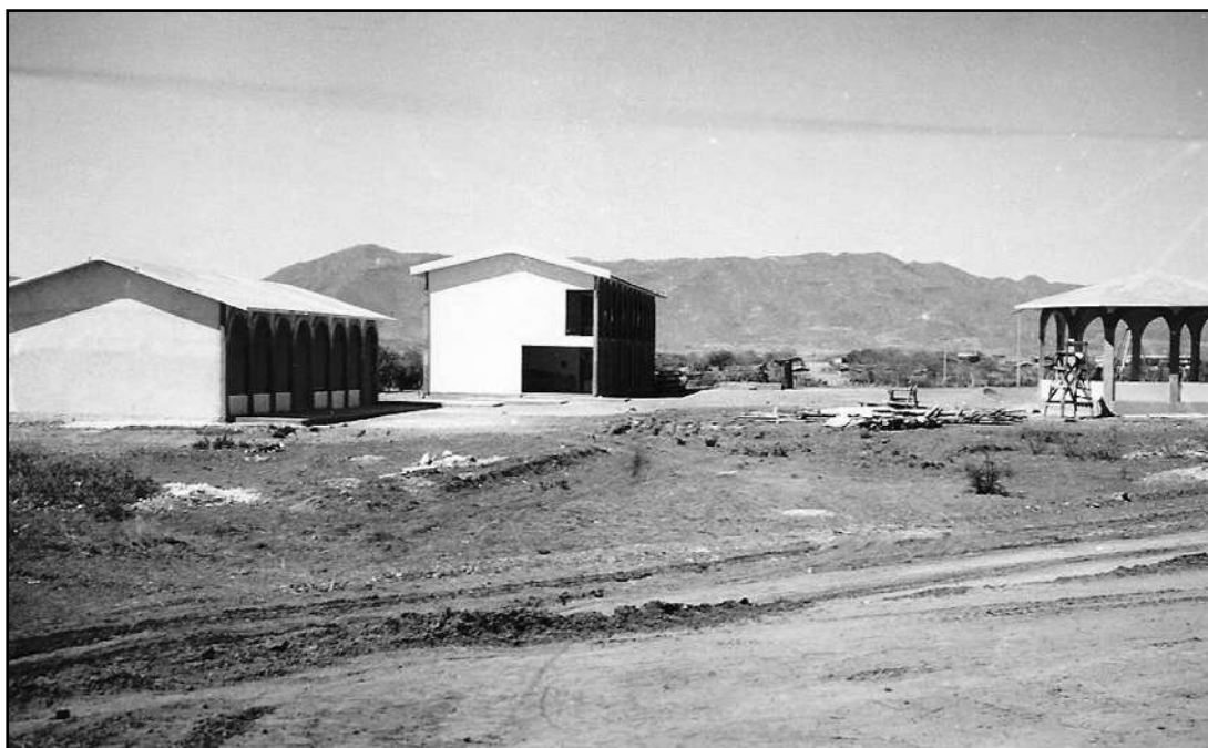
Proceso de construcción de la primera Preparatoria en Huetamo (Foto de J. Jesús Peña Navarrete)
