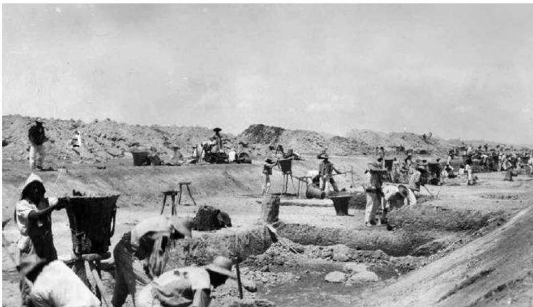
Construcción del dren Guaracha, Fototeca Lázaro Cárdenas, Álbum 1, foto 82, 1932.
