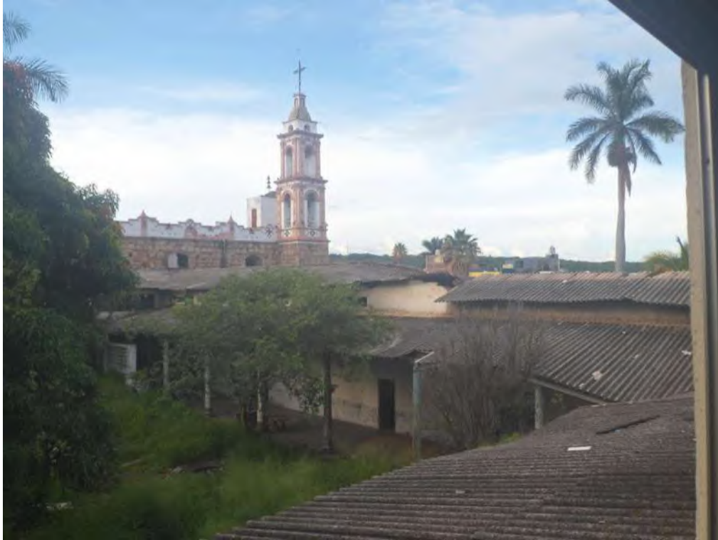
Vista tomada desde el interior del segundo piso del edificio de la exhacienda.
