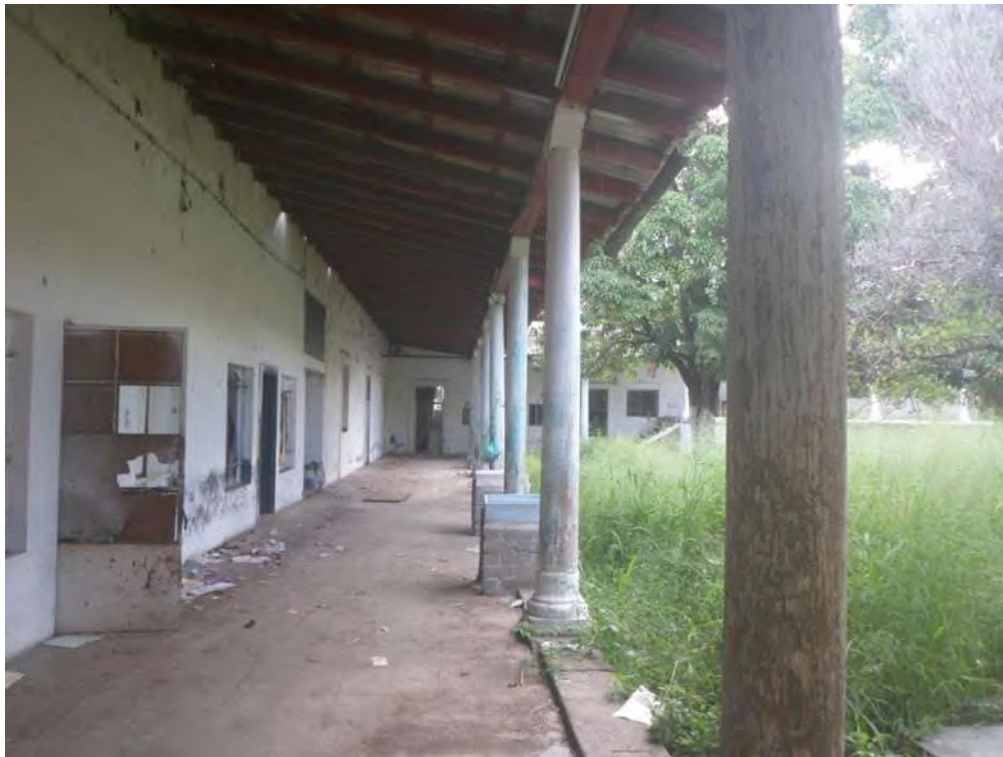
Pasillo interior sur, desde la esquina con el pasillo este. Foto mía (nov. 2019).
