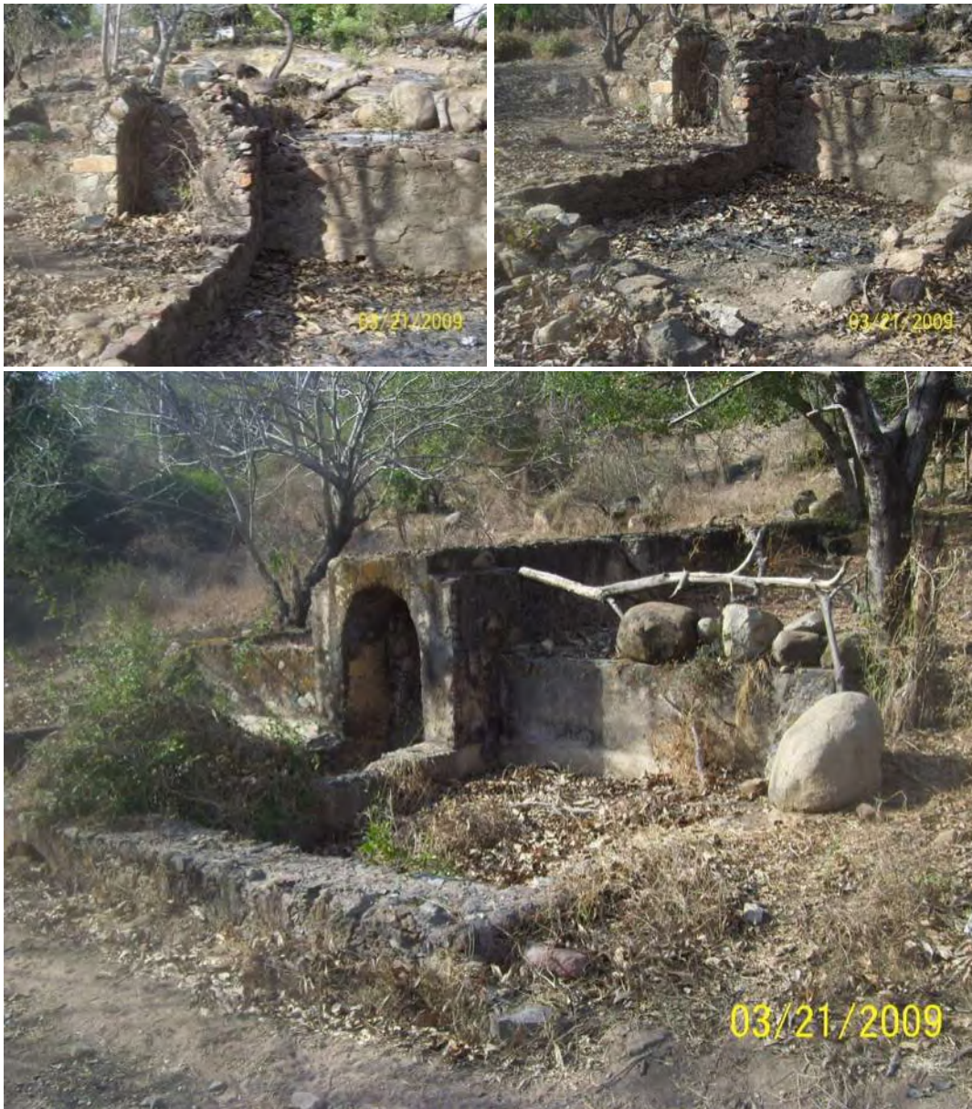
Ruinas de la antigua infraestructura para procesar añil en la hacienda de Poturo. Las imágenes son capturas de video. Sntacruz Villasr, Felipe. Añil en Poturo, Churumuco. Ruinas. Obrajes de la época colonial [video de YouTube]. https://www.youtube.com/watch?v=7jc3j69OVk0 Posiblemente en Nombre de Dios haya habido unas similares.
