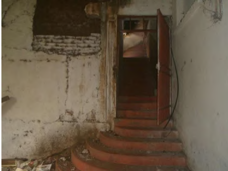
Escaleras a la segunda planta en la esquina de los pasillos este y sur. Foto mía (2019).
