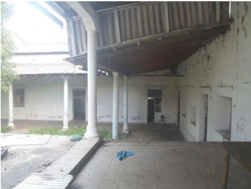
Esquina de los pasillos sur (al fondo) y oeste. Foto mía (nov. de 2019).
