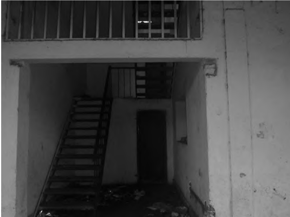
Escaleras a la planta alta, en el pasillo sur. Foto mía (nov. de 2019).
