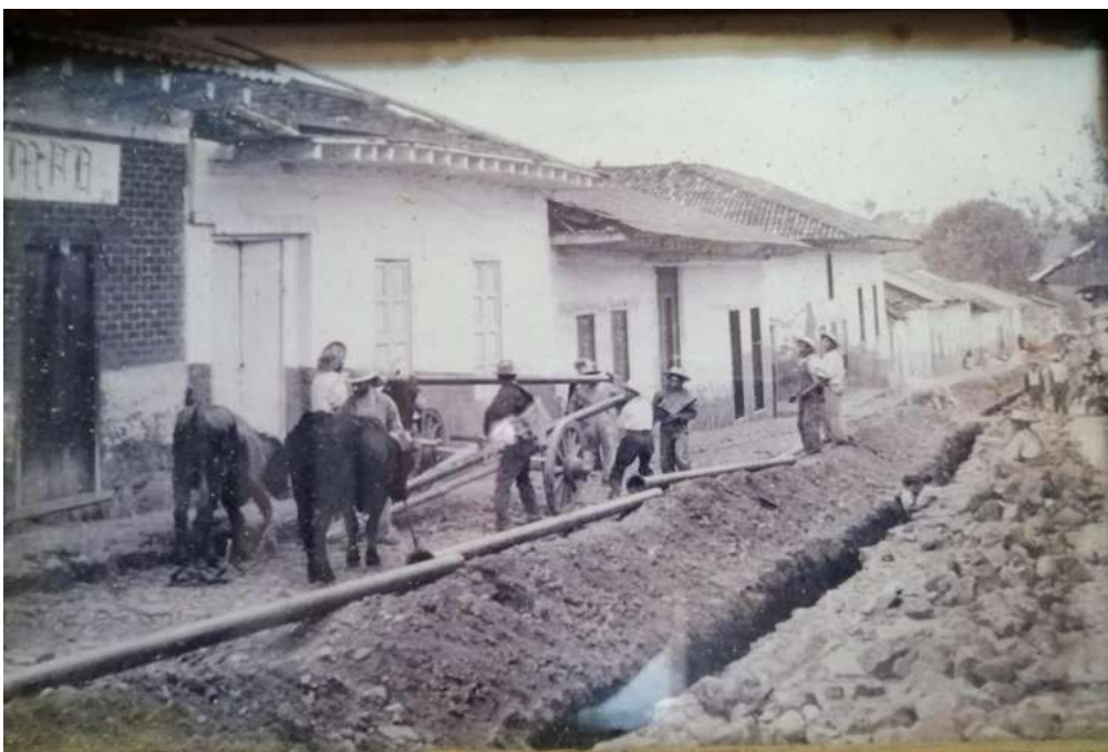
Figura 17." Archivo Fotográfico del Centro cultural Tinganio. Sin fecha. Yunta de bueyes jalando los tubos que se utilizarían para la introducción de la red de agua potable, calle Juárez, Tingambato Michoacán"
