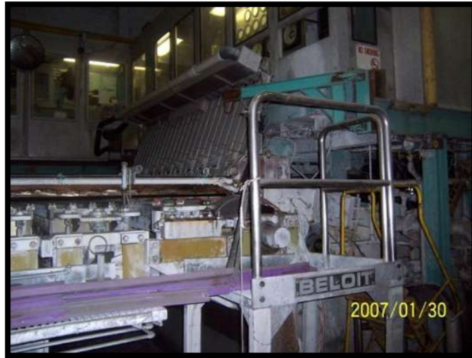
Figura 18 Caja de entrada (torras papel S.A., 2008)
