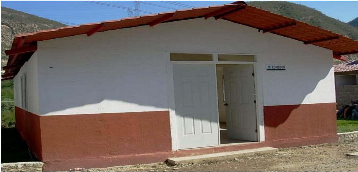
Figura 14 espacio construido para comedor.
