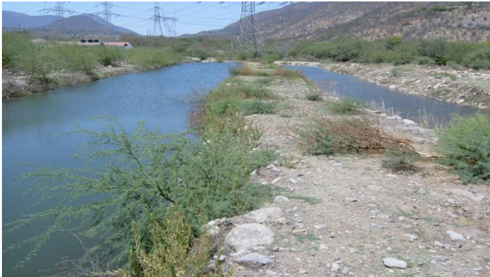
Figura 10 Estanques rústicos de sedimentación utilizados para el desazolve (2 unidades).
