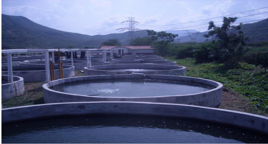
Figura 6 Estanques circulares de concreto utilizados para engorda de reproductores (16 unidades).
