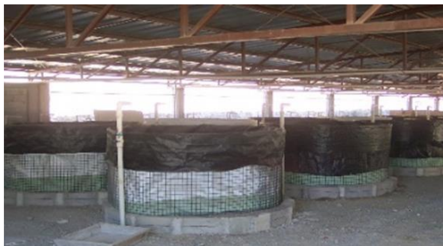
Figura 5 Tanques de geomembrana localizados en el área de criadero (16 unidades)
