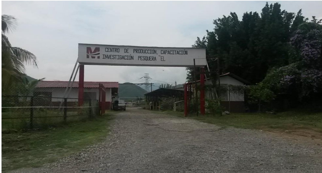
Figura 11 Entrada principal y caseta de mantenimiento del CETAEM.
