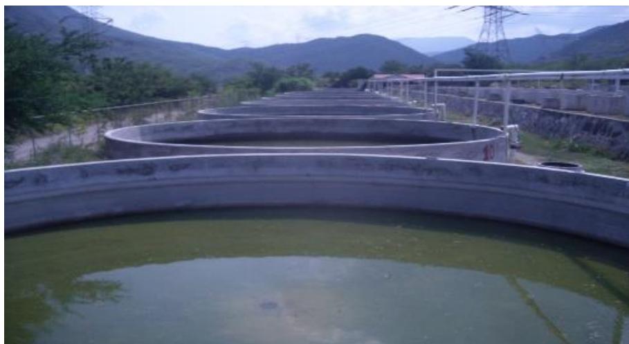
Figura 9 Estanques circulares de concreto utilizados para engorda de juveniles (20 unidades).
