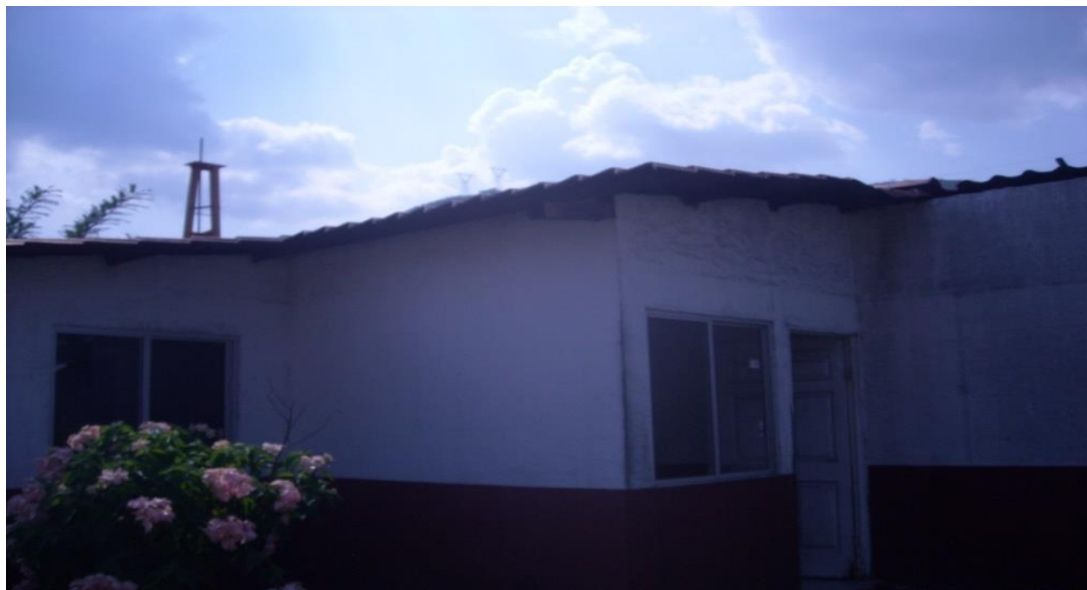
Figura 18 Oficina, espacio donde se realizan las funciones administrativas del CETAEM.
