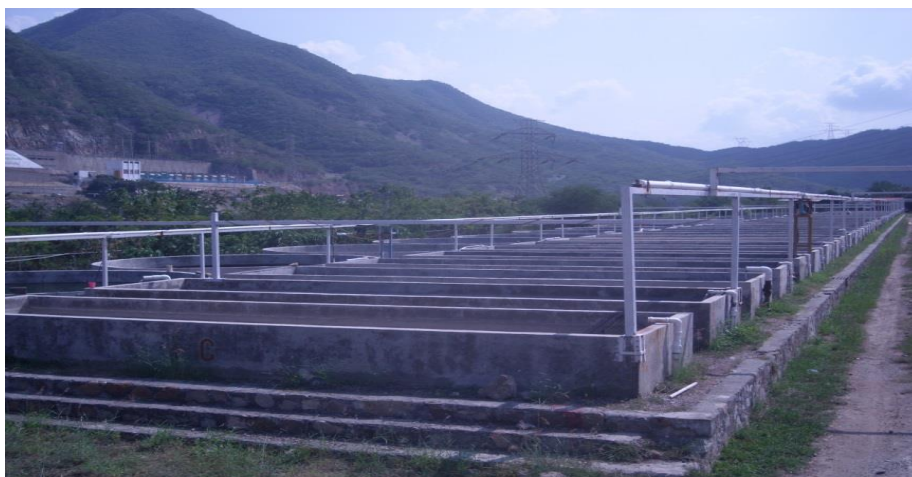
Figura 8 Estanques rectangulares de concreto utilizados para reproducción (54 unidades).
