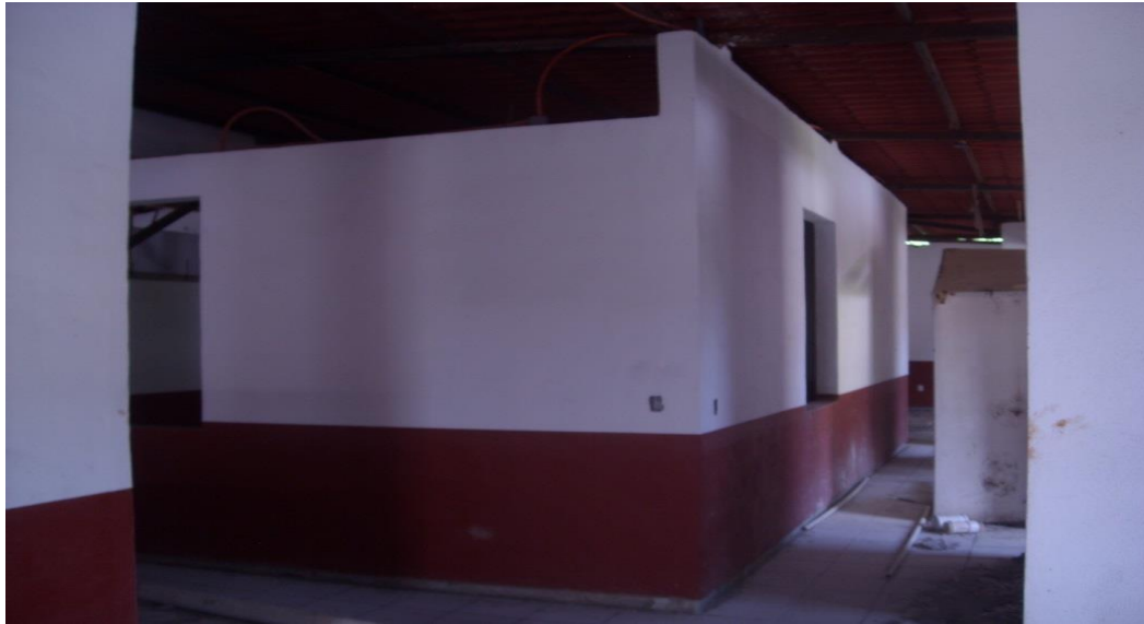
Figura 17 Espacio construido para albergue.
