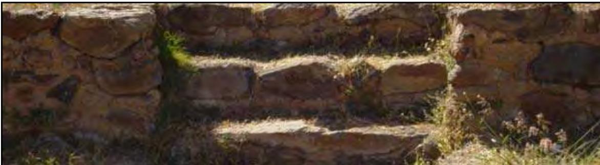
Fig. 49 Aglutinante de arcilla con estiércol en los muros
