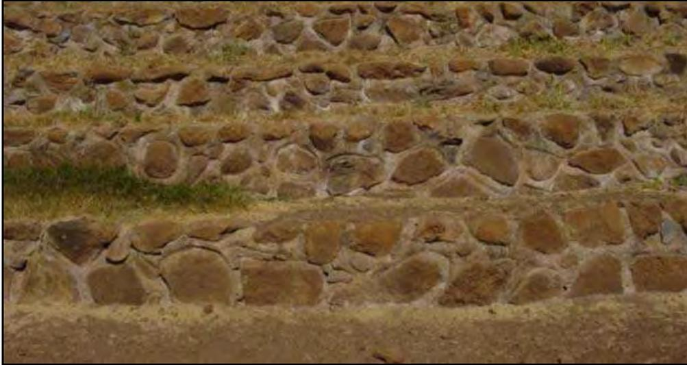
Fig. 50 Muros de roca con aglutinante de arcilla
