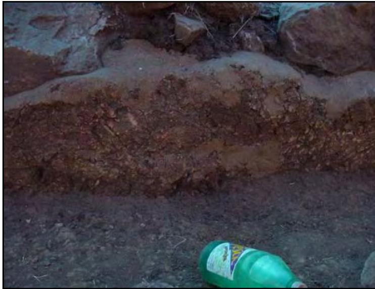
Fig. 48 Aplanado de arcilla en el muro de una plataforma
