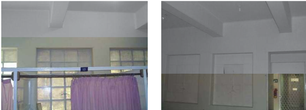
Figs. 9 y 10.- Sanatorio la Salud. Detalles de localización de trabes en elementos con poco apoyo.
