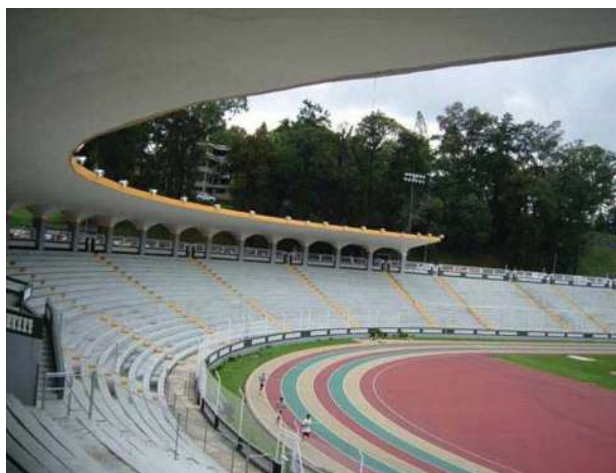
Fig. 1.10.- Estadio municipal de Jalapa, Veracruz, donde se potencializa los usos del concreto no solo en estructura, sino como un elemento plástico.
