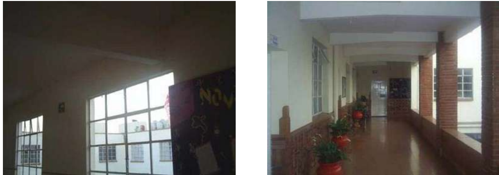
Fig. 24 y 25.- Fotos de detalles constructivos del colegio Anáhuac. Generalmente se tuvo cuidado en aterrizar las Travesaños sobre castillos, aunque en menor medida esto no sucedió como por ejemplo en lo que antes era el laboratorio (izquierda).
