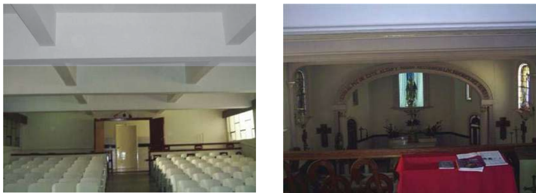
Figs. 11 Y 12.- Auditorio y capilla del Sanatorio La salud. Formación de tableros en de peraltes de 65 y 45cms para solucionar pequeños claros de 3x3mts.
