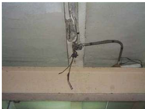
Figs. 13 y 14.- Detalles constructivos. A la izquierda detalle del refuerzo estructural actual para sostener la losa de entrepiso, a la derecha detalle de traveses en planta alta. Fotos del autor.
