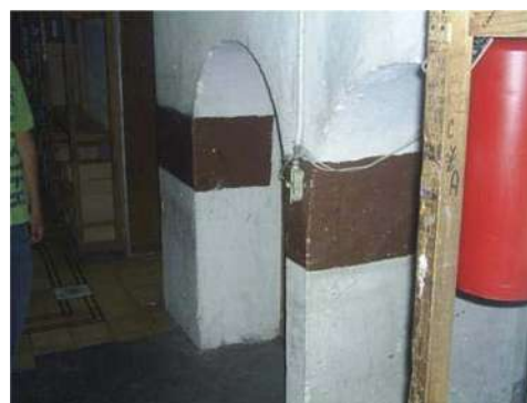
Figs. 6 y 7.- A la izquierda detalle de las traveses en planta alta de la actual Zapatería Tres Hermanos, a la derecha muro de 40cm en planta alta.
