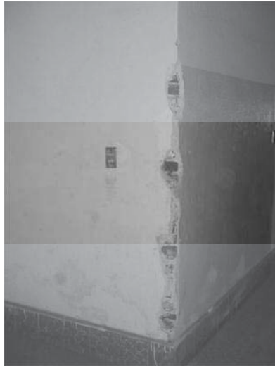
Figs. 4 y 5.- Detalles de la falta de castillo en el edificio de enfermería del sanatorio La Luz.
