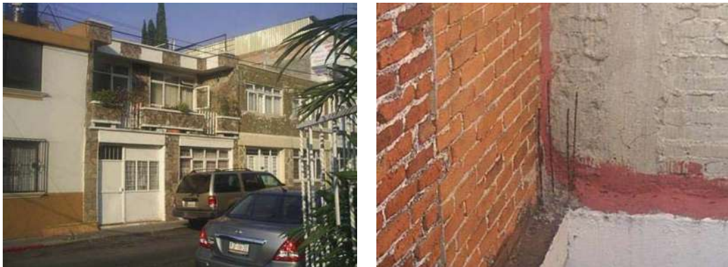
Figs. 38 y 39.- A la derecha casa-habitación Padre Lloreda , a la izquierda, detalle de la rugosidad de la varilla.
