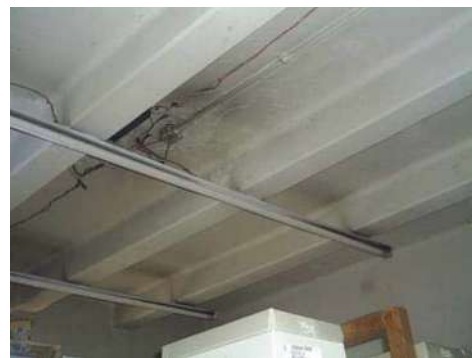
Figs. 13 y 14.- Detalles constructivos. A la izquierda detalle del refuerzo estructural actual para sostener la losa de entrepiso, a la derecha detalle de traveses en planta alta. Fotos del autor.
