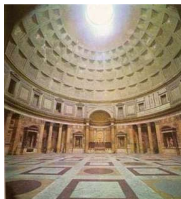
Fig. 1.1 y 1.2.- A la izquierda corte del Panteón en donde la cúpula de 44m de diámetro es resuelta mediante concreto simple. Este recinto no tiene ninguna ventanal la iluminación es resuelta mediante el lucernario central de gran diámetro. La cúpula esta aligerada por medio de casetones. Fuentes:
