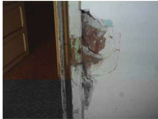
Figs. 4 y 5.- Detalles de la falta de castillo en el edificio de enfermería del sanatorio La Luz.
